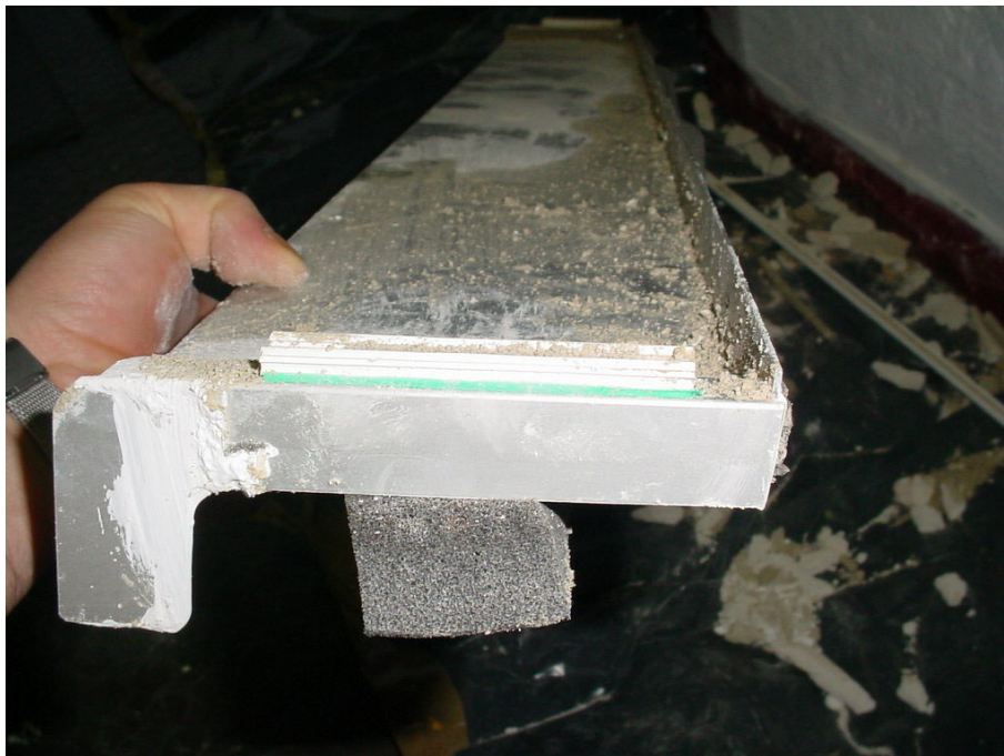
Bild 2 Bauteilprüfung 104 28751, 3win-Fensterbank mit geklebten Bordstücken
